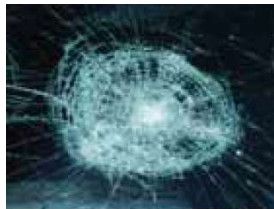
État de brisure du verre feuilleté
