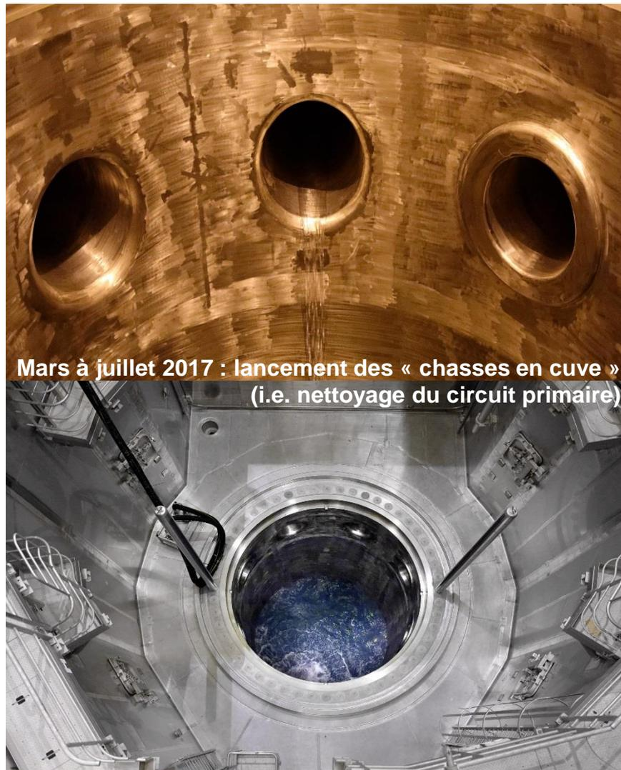
Mars à juillet 2017 : lancement des « chasses en cuve » (i.e. nettoyage du circuit primaire)
