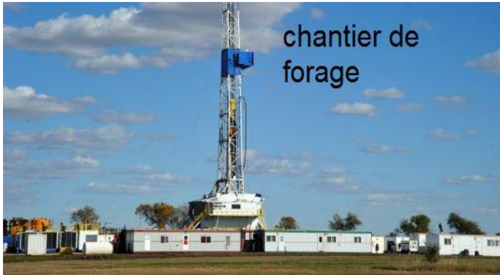
Chantier de forage
