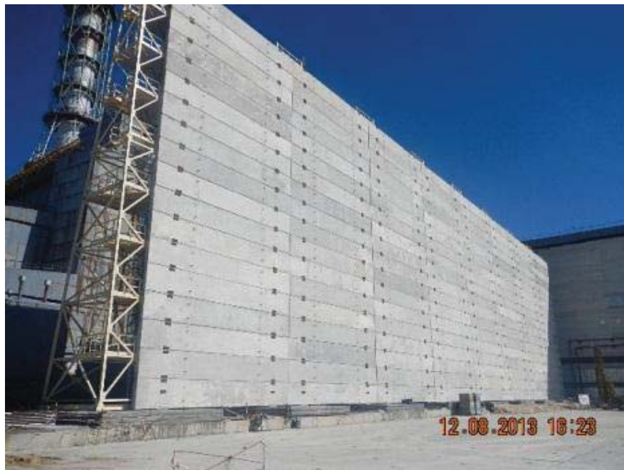
Mur de protection biologique pour la construction du « technical building ». Zone Local (2013)
