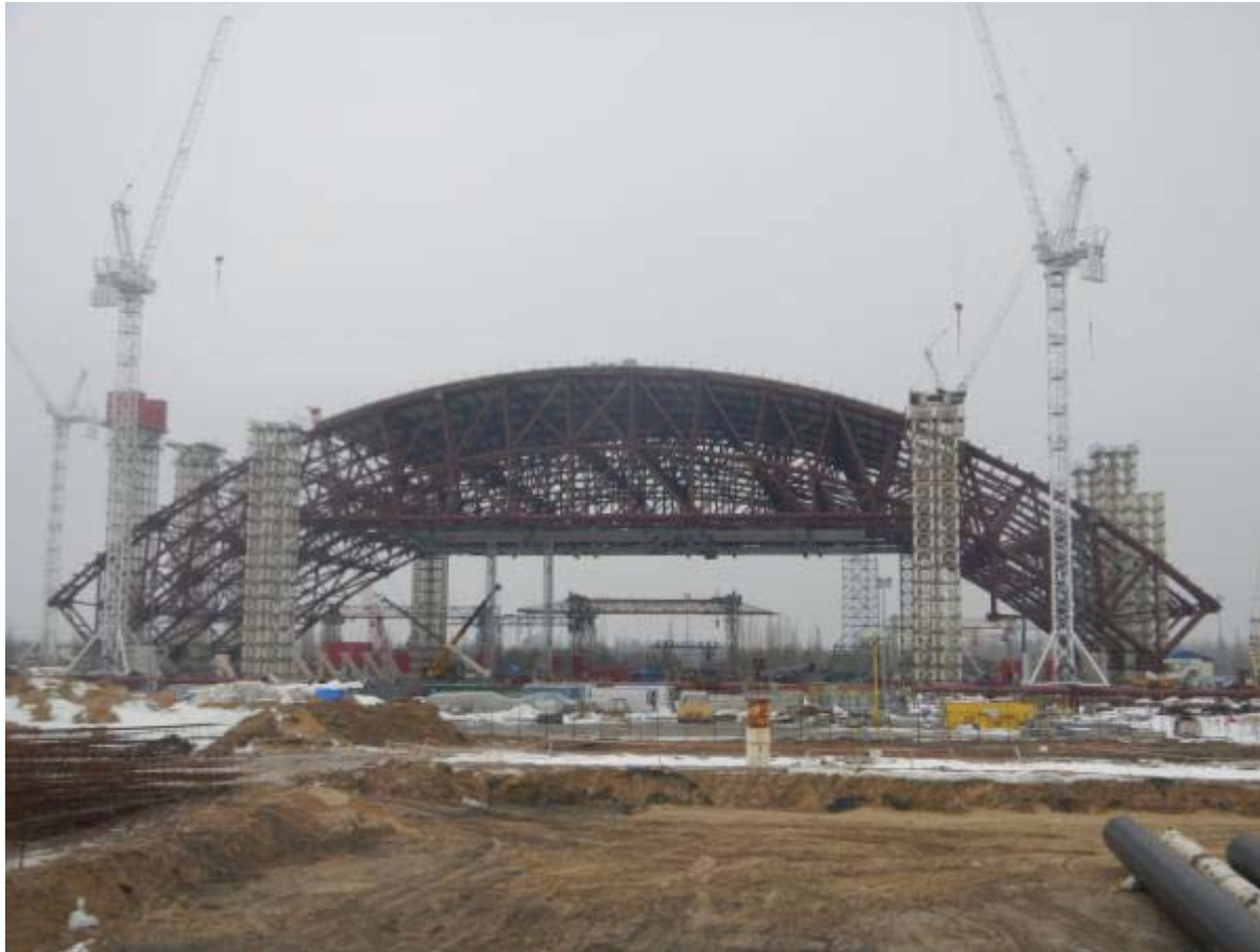
Montage de l'arche Fin 1 er levage Zone FAA (2013)
